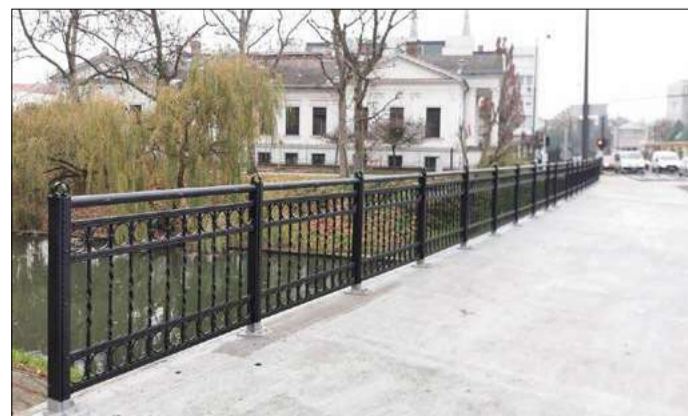
Korhű hidkorklátót kapott a Munkácsy-híd
